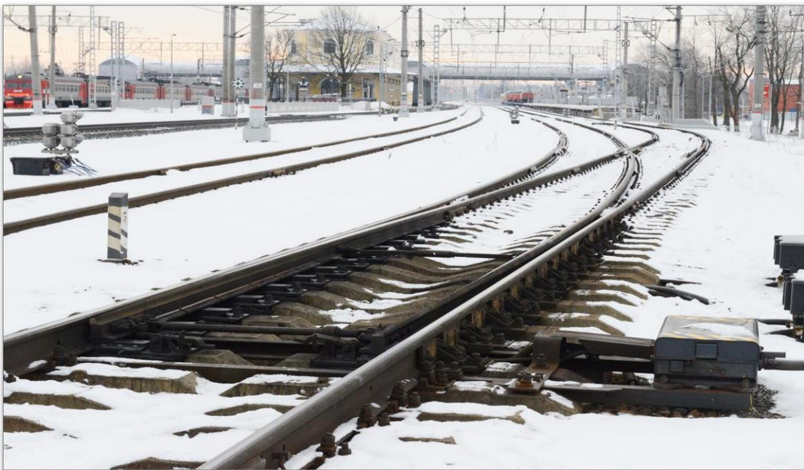
Рисунок 9. Оборудованный электрообогревом стрелочный перевод
